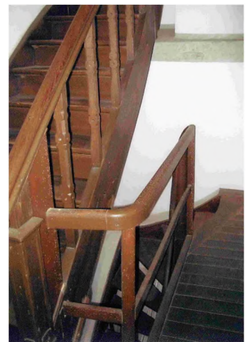
Aus Brandschutzgründen wurde die Holztreppe gegen eine Betontreppe ausgetauscht.
