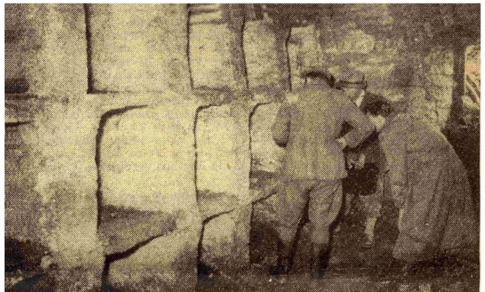
Die einzelnen Zellen der Totenkammer sind neben- und übereinander gelagert. Im Jahre 1954 wurde der erste Keller für die neue Heizungsanlage der Kirche freigeräumt, und die Heizung wurde dort installiert.
