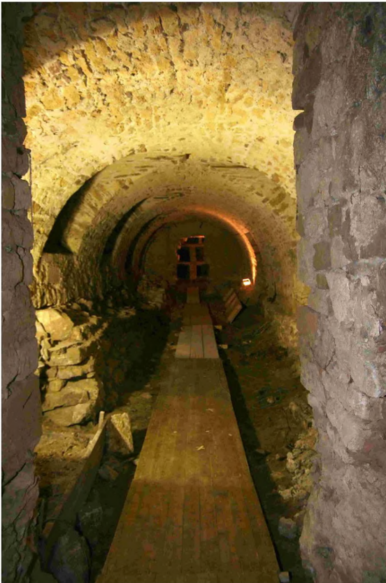
Durch diesen Gewölbegang des Westflügels gelangt man bis an den Mauerdurchbruch in die Grabkammer.
