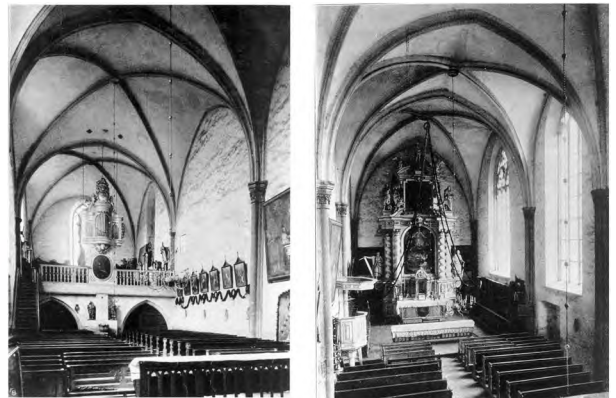
Innenansichten nach Westen und Osten, Aufnahmen von 1897. Beide Bilder und Bilder links entnommen aus Bau- und Kunstdenkmäler von Westfalen, Kreis Warburg, erschienen 1939 im Aschendorffverlag Münster.
