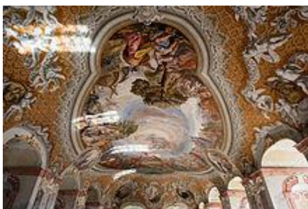
Das restaurierte Gewölbe im Klosterrefektorium
