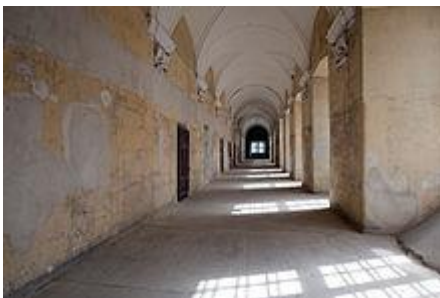
Einer der unsanierten Gänge im Kloster
