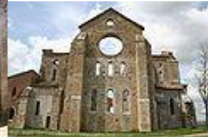
Blick gegen den Chor von außen
