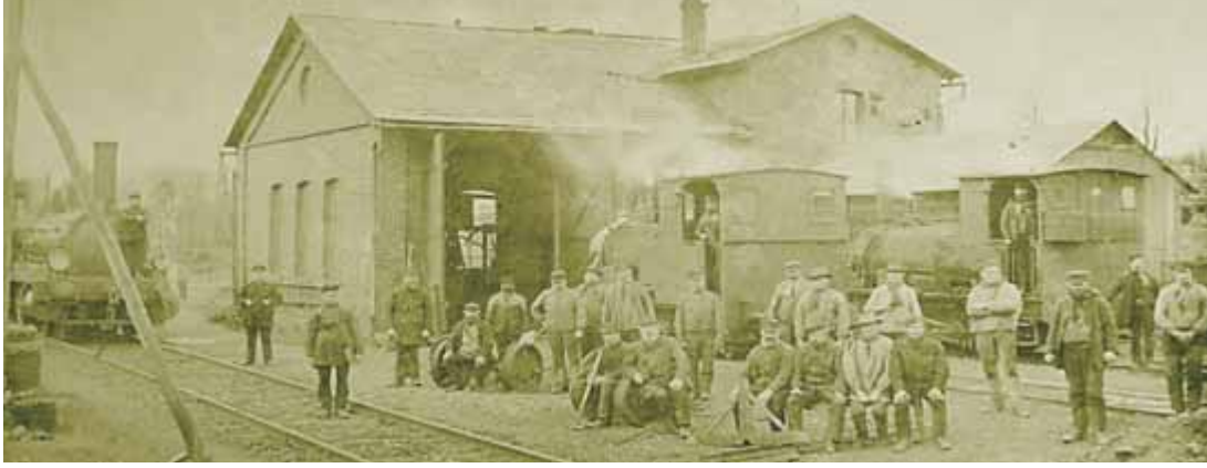
Abb. 10: Lokschuppen der Rhene-Diemeltalbahn in Bredelar
