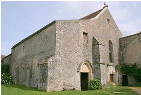
La façade de l'église
