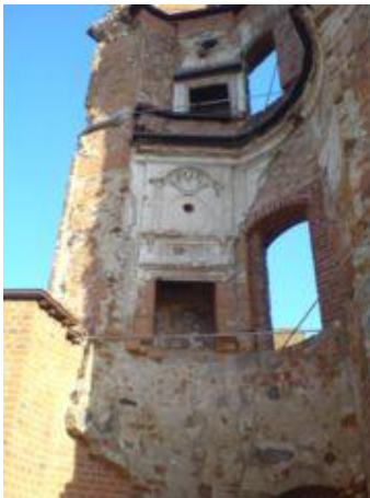
Ruine eines Turms mit Stuckresten und Kaminöffnungen
