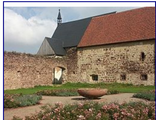
Abbildung 1: Bereich des ehemaligen Kreuzgangs
