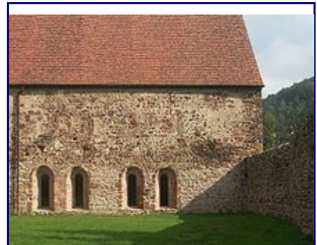
Abbildung 6: Das Südende des Kapitelhauses
