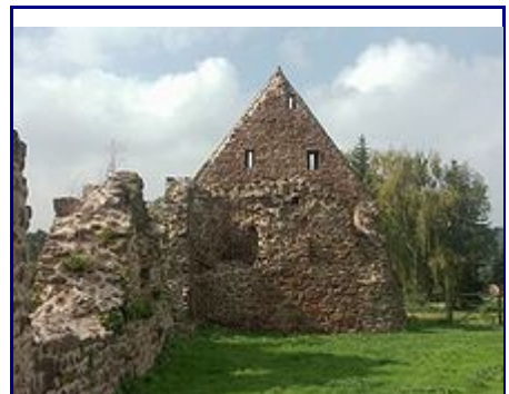
Abbildung 8: Ruine des ehemaligen Brau- oder Malzhauses im Laienbereich
